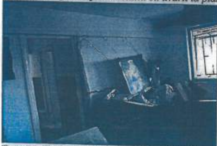
Foto 14. Etaj IV. Ap30. Detaliu avarii, dislocarea pereților interiori de compartimentare din zidărie de BCA.
