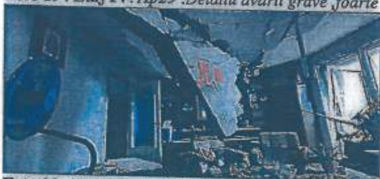
Foto 20 . Etaj III. Ap27.Placa planșeu peste etaj III, cu avarii foarte grave.
