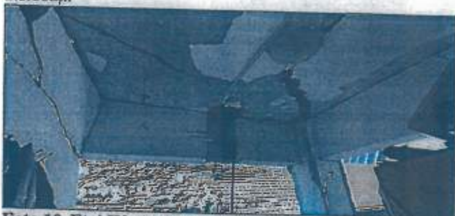
Foto 10. Etaj IV. Ap.31 .Detaliu cu avarii grave ale plăcilor de planșeu.
